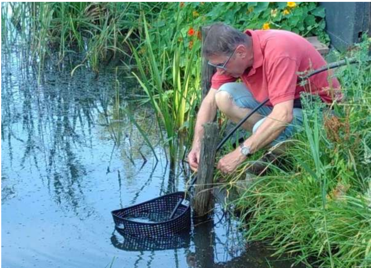
Foto-19 Grofvuilfilter vastmaken in de sloot
