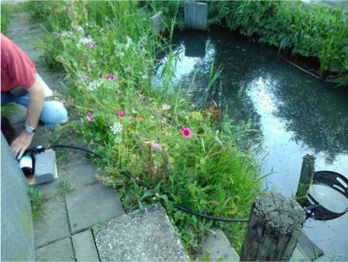
Foto-16 van filtermand naar pomp-fijnfilter
